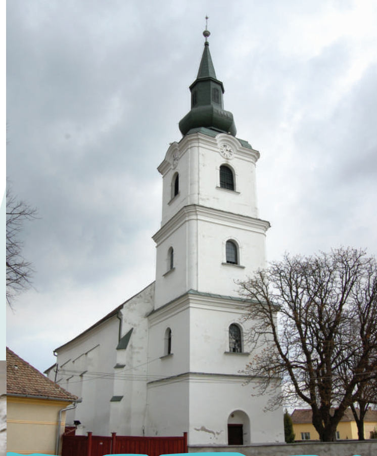
Biserica reformată • Nușfalău
